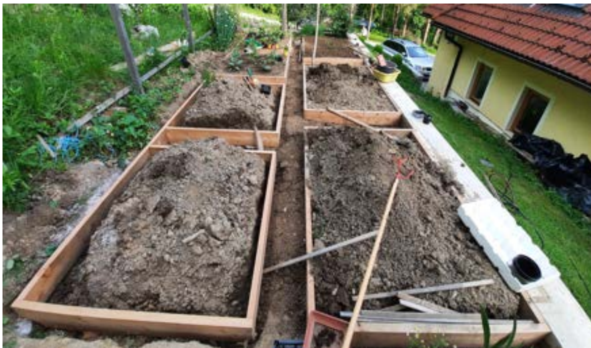
Slika 17: Vrt med procesom prenove Vir: Cehner, V., 2021
