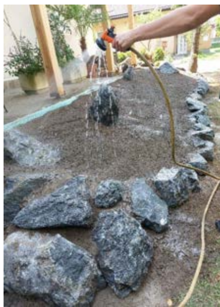
Slika 32: Utrjevanje prvega sloja Vir: Urša Črep
