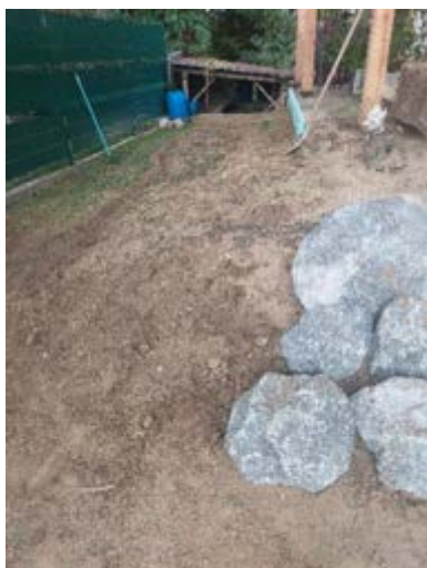
Slika 23: Ureditev oblike grede izgradnja suhozida Vir: Urša Črep
