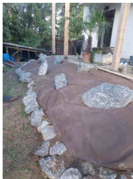
Slika 38: Zaključeno polaganje folije Vir: Urša Črep
