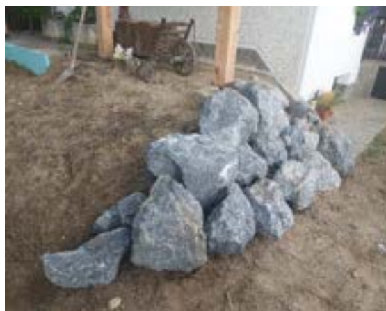
Slika 26: Zaključek suhozida Vir: Urša Črep
