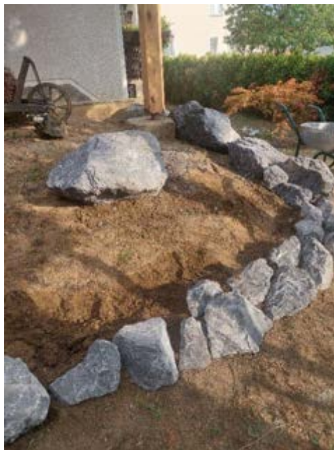
Slika 28: Postavitev večjih skal in njihova utrditev Vir: Urša Črep
