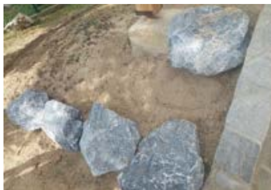
Slika 24: Postavitev začetka suhozida Vir: Urša Črep
