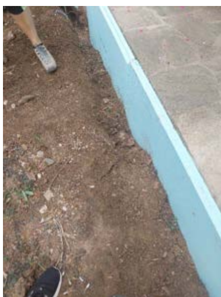
Slika 19: Pritrditev stirudur plošč Vir: Urša Črep
