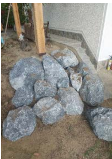
Slika 25: Izdelava suhozida ob terasi iz skal Vir: Urša Črep
