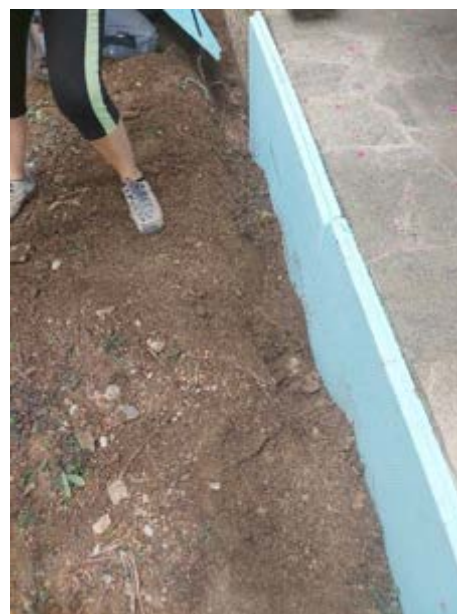
Slika 20: Zasipanje plošč Vir: Urša Črep
