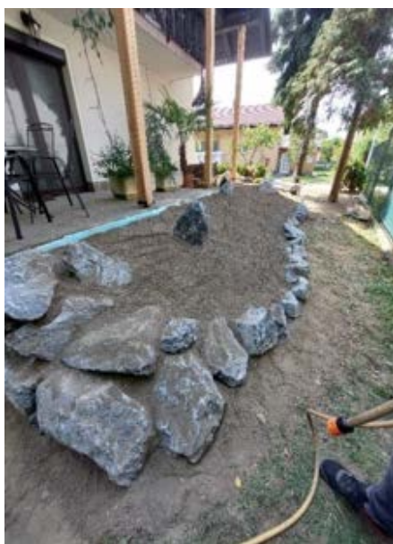
Slika 31: Dodajanje prvega sloja nasutja Vir: Urša Črep
