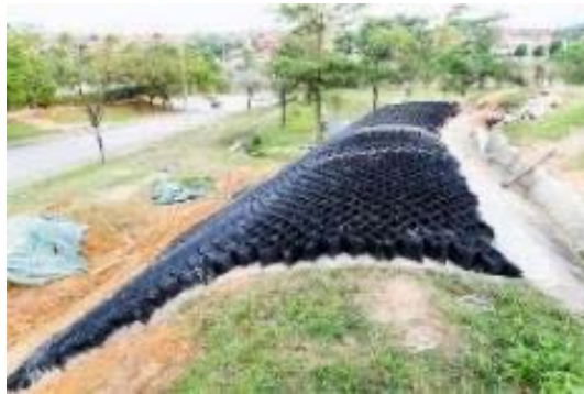
Slika 11: Ojačitev brežine z geomrežo
