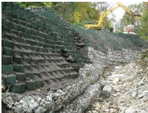
Slika 4: Strma brežina, pripravljena z žepi
