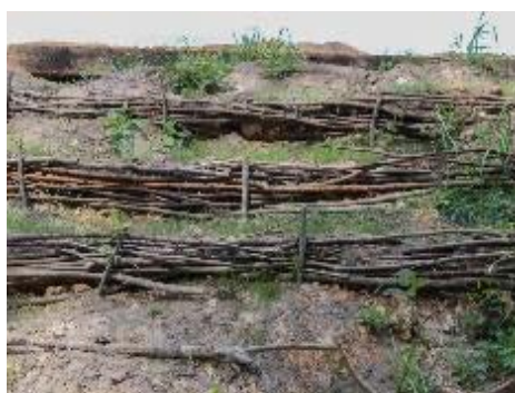
Slika 2: Brežina urejena s terasami s plotom
