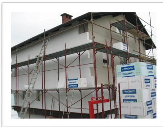
Slika 23: Ekspandirani polistiren v fasadi (33)
