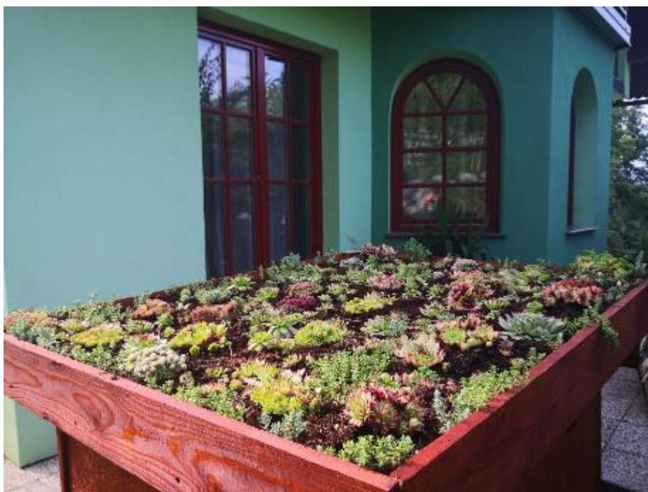
Slika 36: Vegetacijski sloj (ekstenzivna ozelenitev) Vir: Suzana Loparič, 2021
