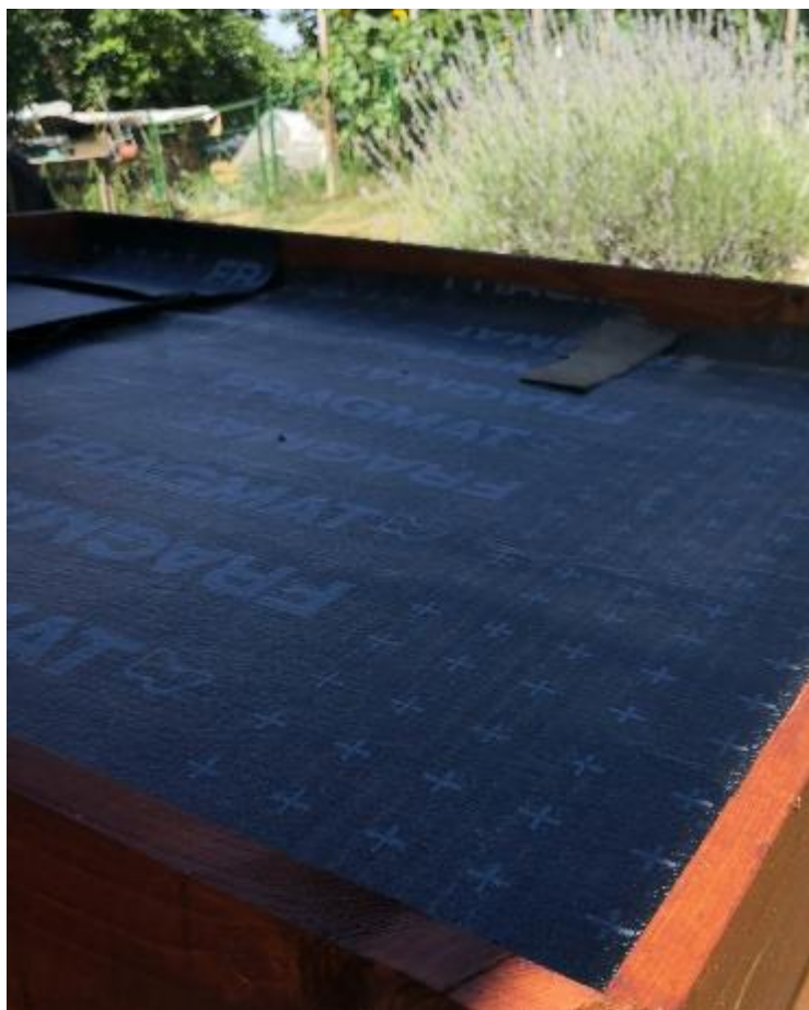
Slika 34: Protikoreninska hidroizolacija Fragmat
