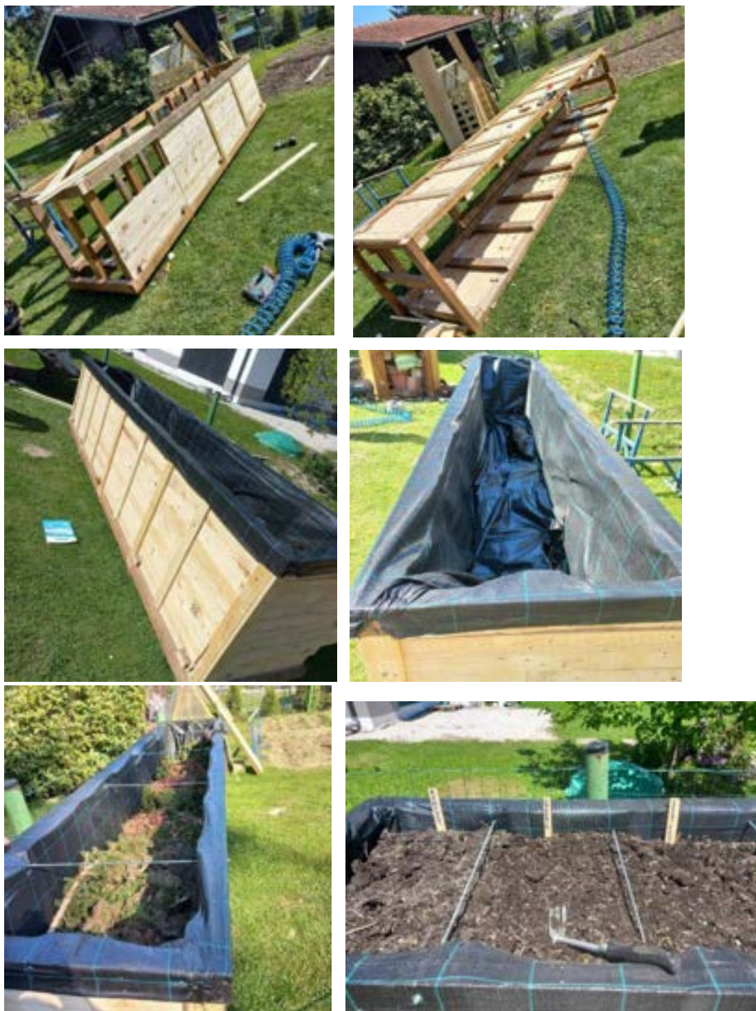
Slika 21: Izdelava visoke grede (27)
