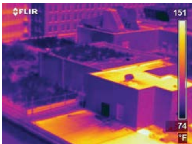
Slika 65: Termovizijska slika strehe
