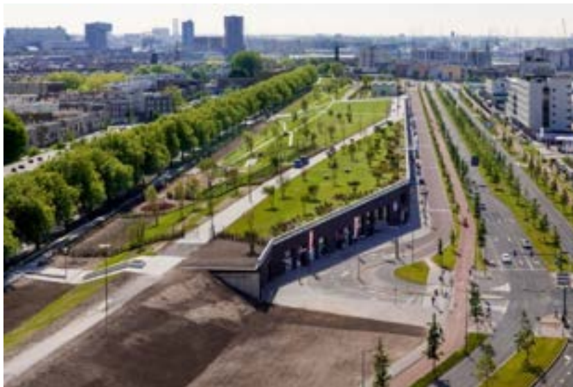
Slika 23: Strešni park »Four Harbour Roof Park« – Rotterdam (Nizozemska)
