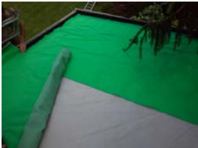
Slika 96: Polaganje geotekstila
