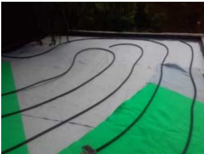
Slika 99: Končni izgled polaganja namakalne cevi Vir: VESELINOVIČ, Marko. 2016. Osebni foto arhiv.
