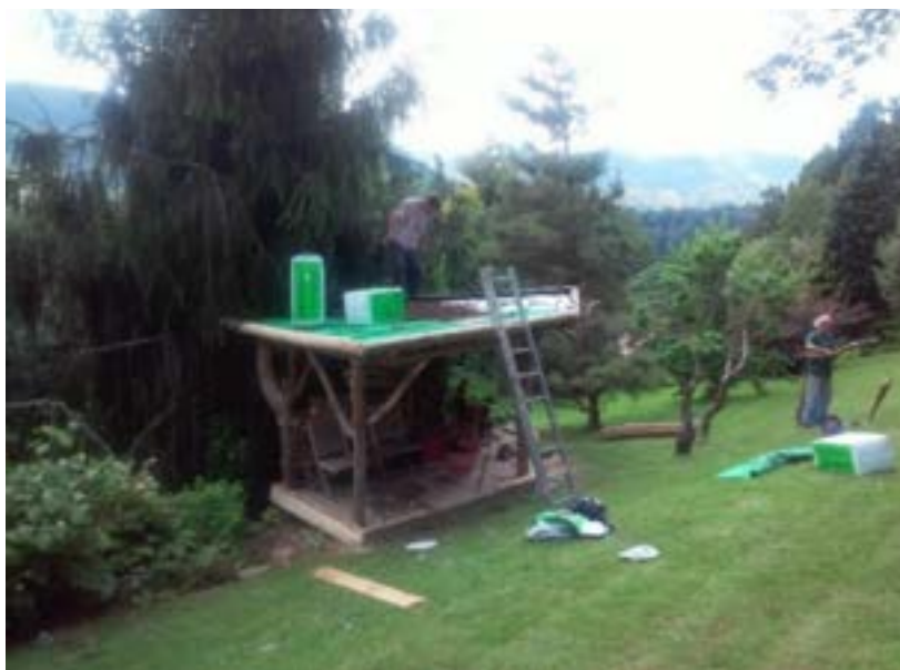
Slika 102: Postavljanje substratnega sloja Vir: VESELINOVIČ, Marko. 2016. Osebni foto arhiv.
