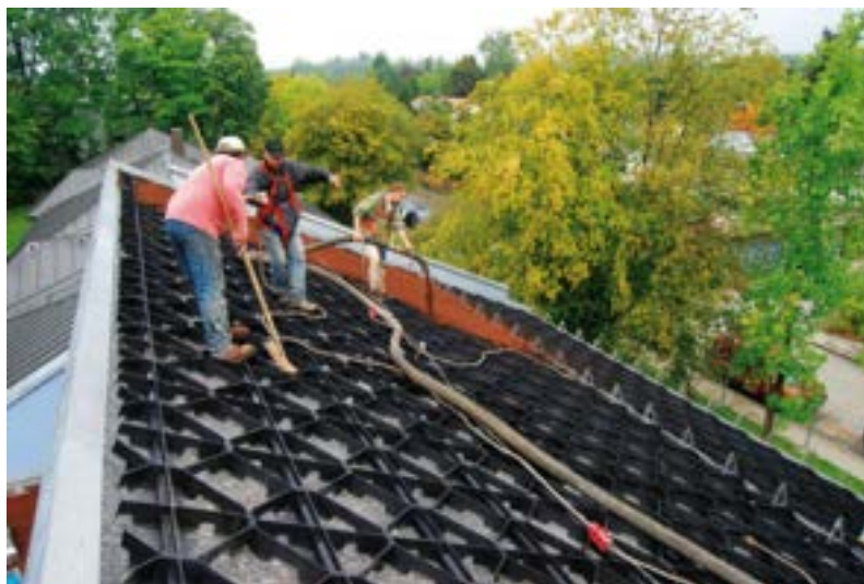
Slika 78: Izdelava zelene strehe s priklopnim sistemom »georaster«
