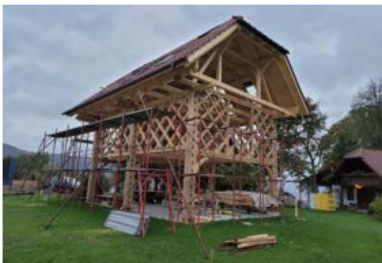
Slika 4: Prenova kozolca v sklopu projekta Nazaj k naravi [12]
