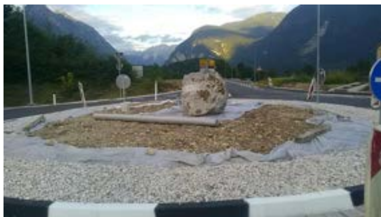
Slika 24: Krožišče pred začetkom zasaditve
