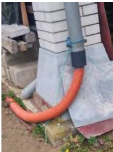
Slika 7: Zbiranje deževnice v rezervoar
