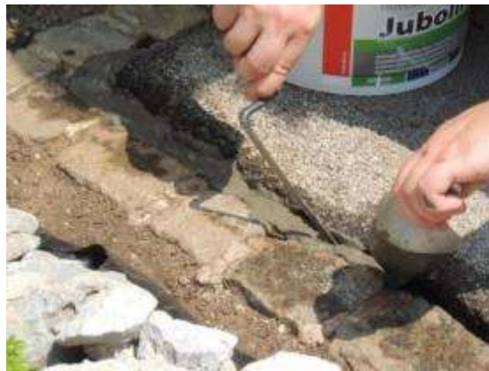
Slika 7: Fugiranje očiščenih špranj
