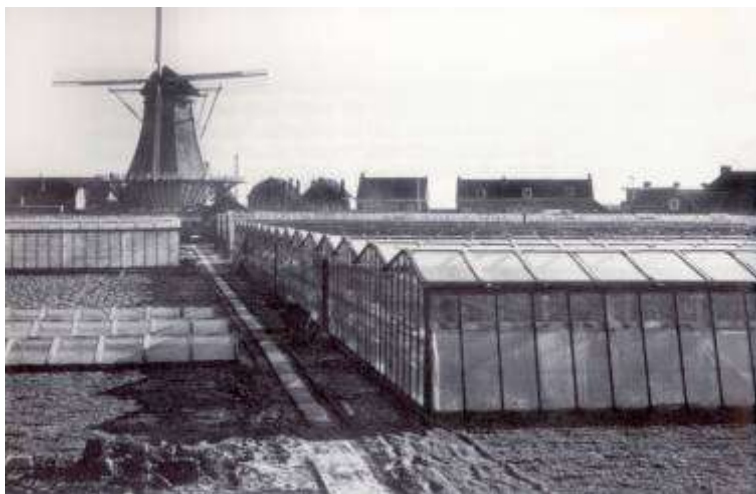
Slika 2. Lesena konstrukcija rastlinjakov na Nizozemskem. Okoli leta 1955. Vir: Maters, H.J
