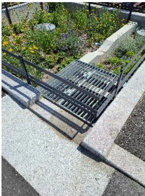
Slika 1: Kompleksno urejena retenzijska greda ob cesti z lovilec usedlin s cestišča in ločenim mestom za razsoljevanje, Dunaj 2025; Vir: lasten
