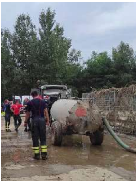
Slika 5: Črpanje razredčene naplavine s cisterno
