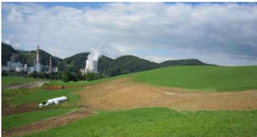
Slika 17: Degradirana površina po izvedeni (začasni) rekultivaciji Vir: arhiv PV, 2014
