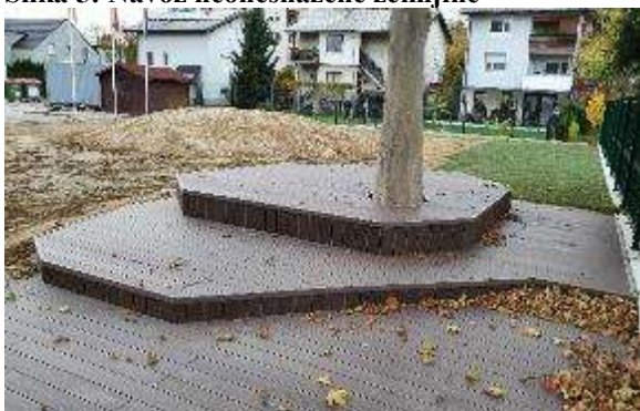
Slika 7: Ureditev podestov pod drevesi med sanacijo igrišča
