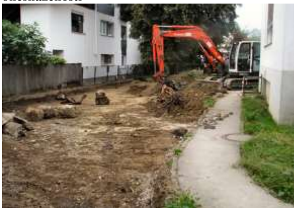
Slika 3: Odkop onesnaženih tal iz otroške igrišča
