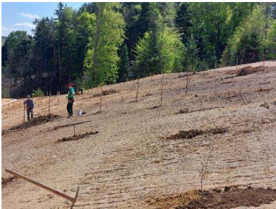
Slika 5: Primer oživljanja degradiranih površin z dodajanjem rodovitne zemlje, zeolita in biogrene na gradbišču avtoceste
