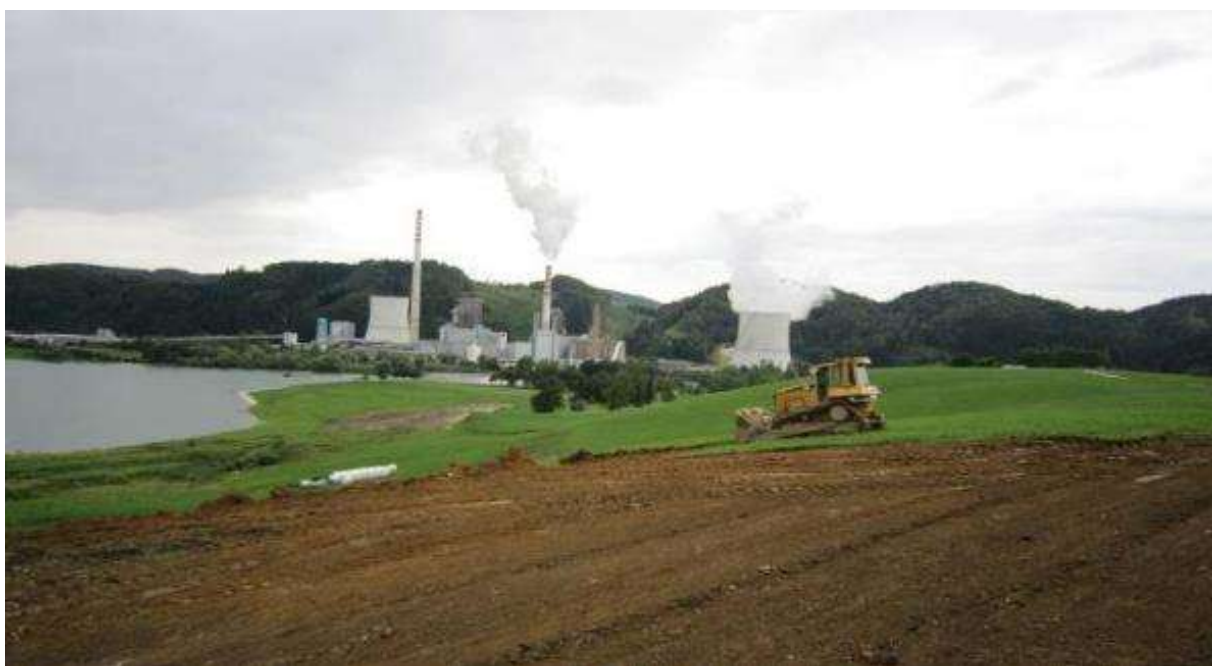
Slika 16: Degradirana površina med izvajanjem sanacije in rekultivacije
