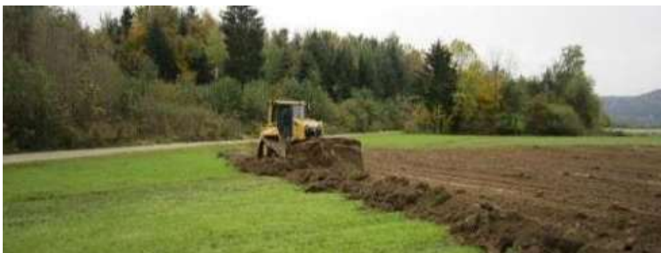
Slika 19: Odstranitev rodovitne prsti preden se teren posede Vir: arhiv PV, 2018
