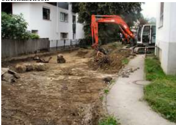
Slika 3: Odkop onesnaženih tal iz otroške igrišča
