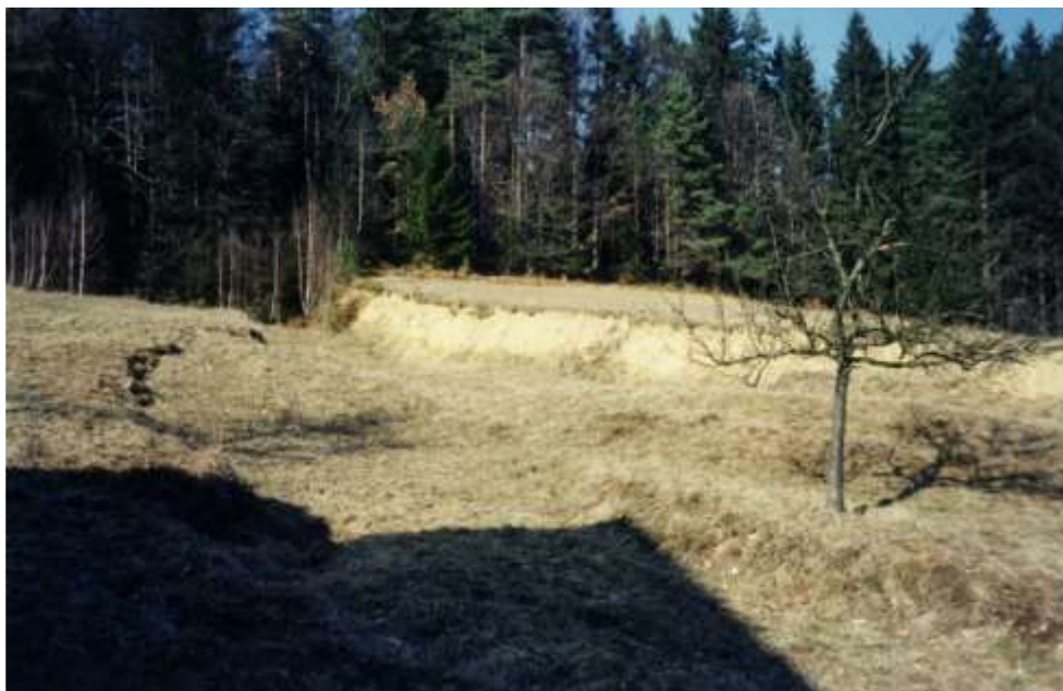
Slika 13: Posledice rudarjenja v PV se kažejo v obliki posedanja površine in nastajanja razpok Vir: arhiv PV, 2010
