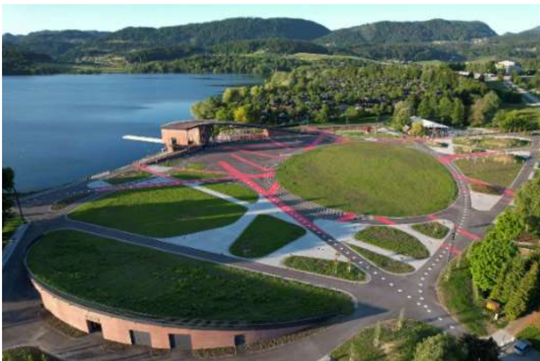
Slika 23: Nova raba površin po izvedeni rekultivaciji degradiranega širšega območja vzhodne obale Vir: https://www.visitsaleska.si/sl/vista/ , b.d.
