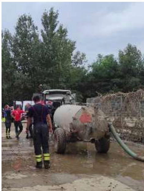
Slika 5: Črpanje razredčene naplavine s cisterno
