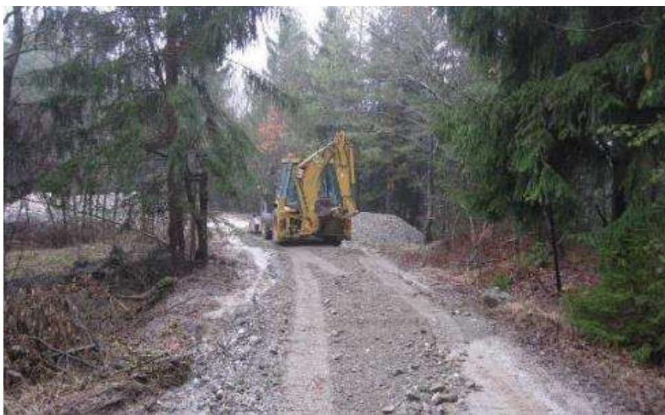
Slika 18: Sanacija in vzdrževanje dostopnih poti Vir: arhiv PV, 2024
