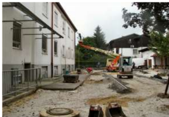
Slika 4: Polaganje tamponske cone
