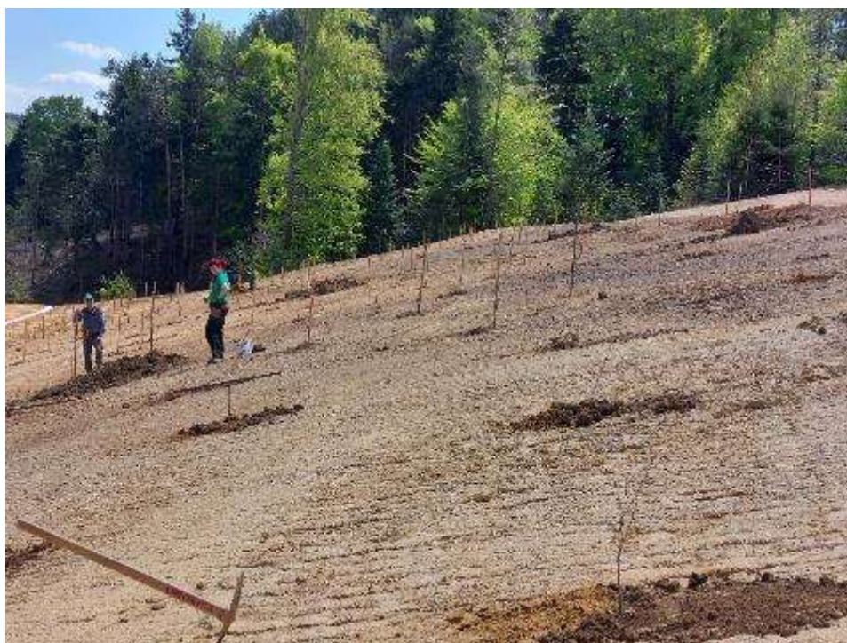
Slika 5: Primer oživljanja degradiranih površin z dodajanjem rodovitne zemlje, zeolita in biogrene na gradbišču avtoceste
